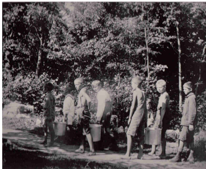
Wasserversorgung, vermutlich aus dem Reservoir der Gemeinde
