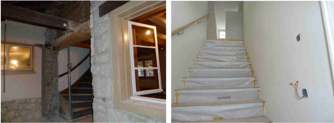
alte Treppe zum Obergeschoss
