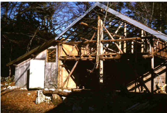
Abbruch des Schopfes
