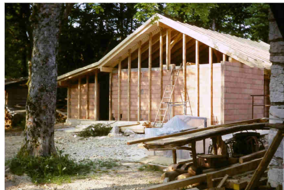
Neubau des Sanitärtrakts 1990
